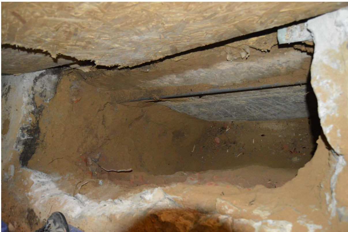
Foto 11: Pohled do výkopu kopané sondy u venkovní strany JV nároží stěn TH vestavku
