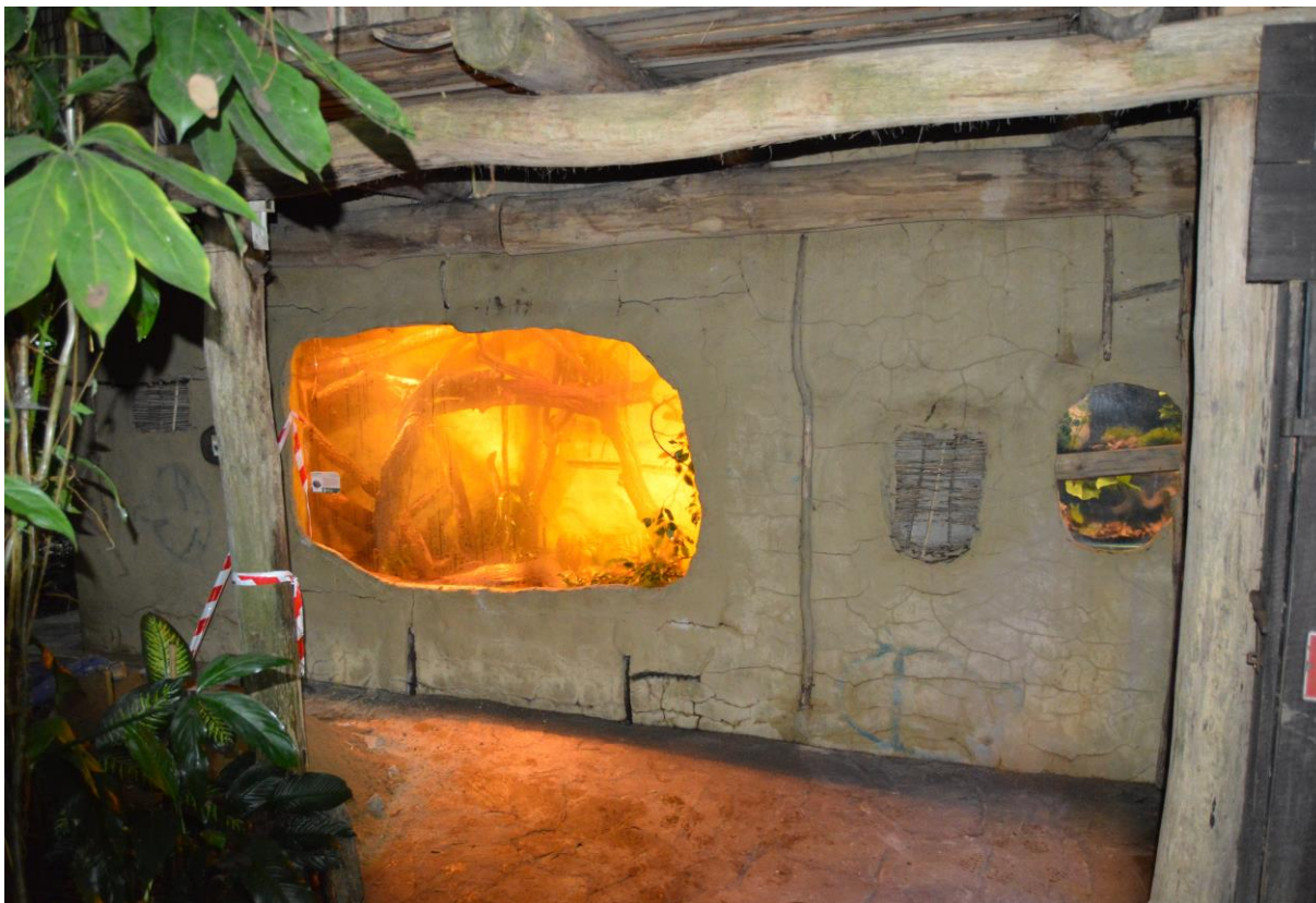
Foto 6: Pohled na východní průčelí TH vestavku - skleněná výplň okna terária
